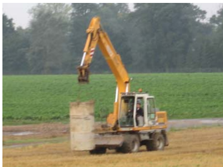
Photo 3. Installation du lysimètre dans la fosse creusée en séparant les horizons de sol
