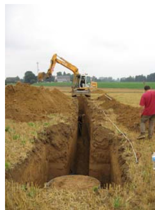
Photo 4. Creusement de la tranchée entre le lysimètre et la chambre de visite
