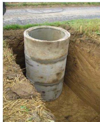
Photo 4. Creusement de la tranchée entre le lysimètre et la chambre de visite
